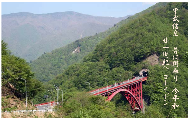
会いの丘からみる豆焼橋と奥秩父トンネル、この先が雁坂トンネル
