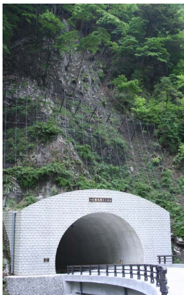
建設中のトンネル。
