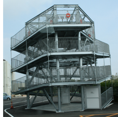
旭市三川地区に完成した避難タワー
