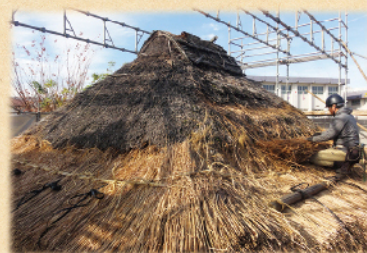
屋根の材料の茅を整えている様子
