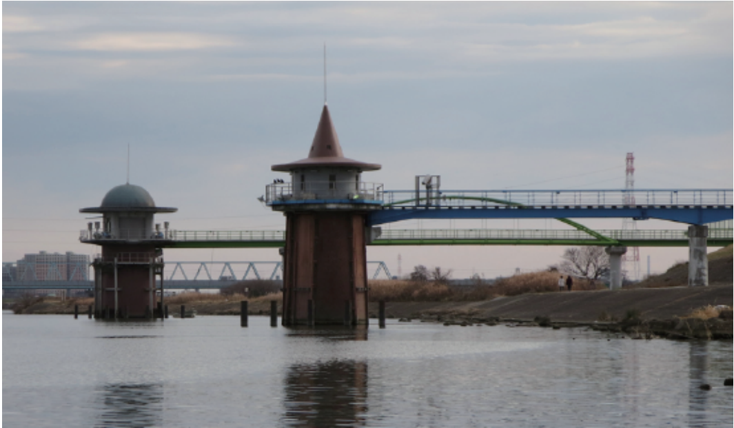
②金町浄水場付近
