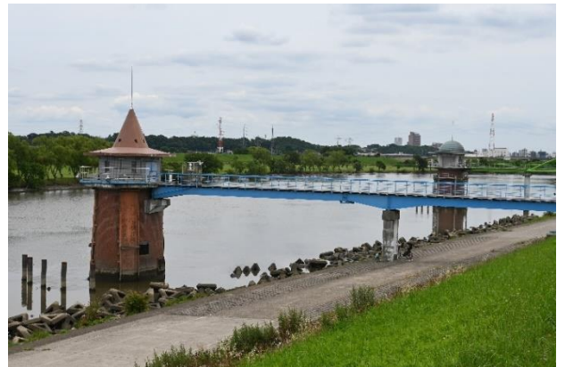
江戸川と金町浄水場
