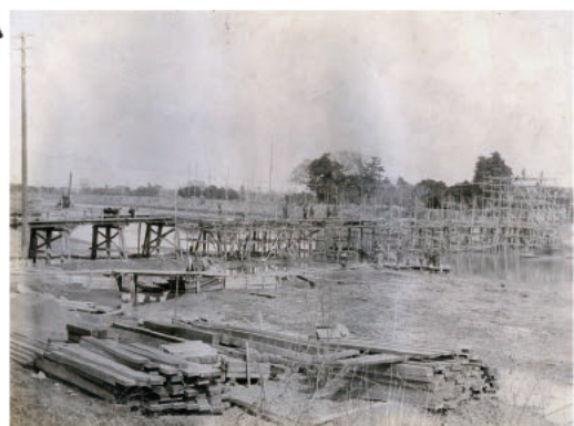
10 中川橋工事の様子 19~20 世紀
