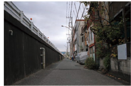
7 中川放水路堤防脇
