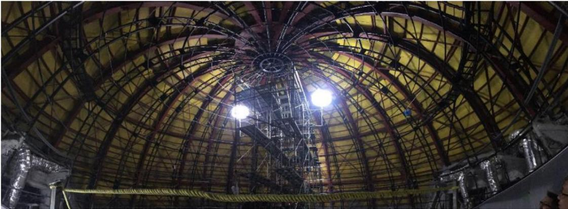
11月29日と30日でドームスクリーン裏にあった音響スピーカーも撤去された。12月12日には、新しいスピーカーが取り付けられ、その後、音の反響を防ぐためのグラスウール(吸音材)も取り付け、新しいスクリーンを張り始める予定。
